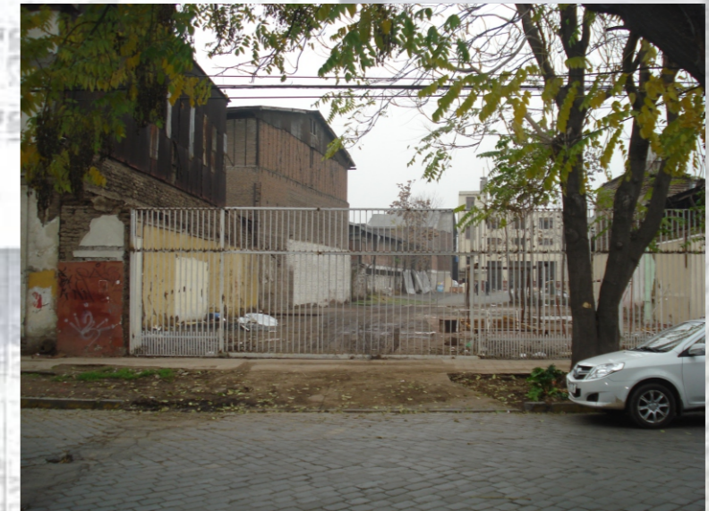
FRENTE TERRENO A INTERVENIR, VISTA DESDE CALLE MARURI. FUENTE: AUTORÍA RAMIRO PALACIOS TORO
