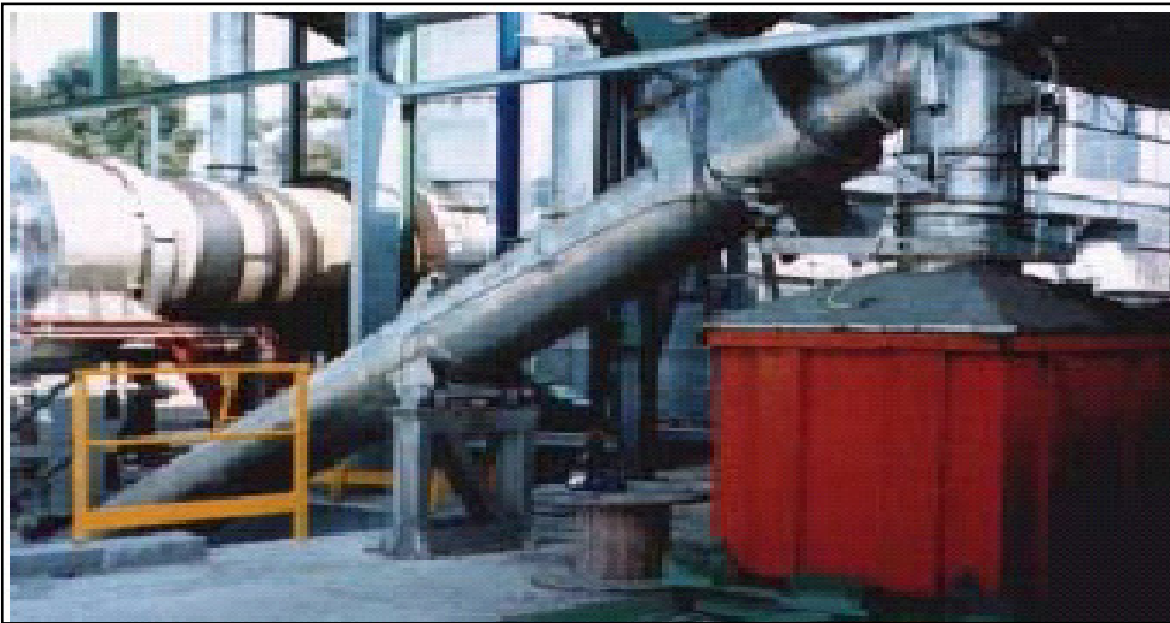
Figura 5.5 Extracción de Residuos Inertes
