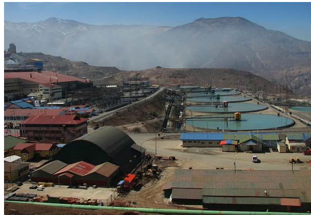
Figura N° 4.11: Disposición de espesadores relaves. 38
