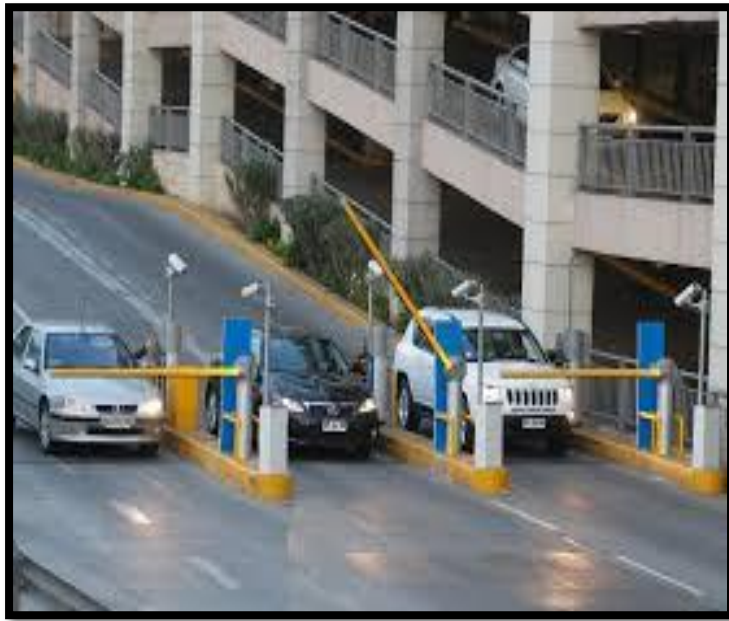
Ilustración 19: Estacionamiento perteneciente a Malls.
