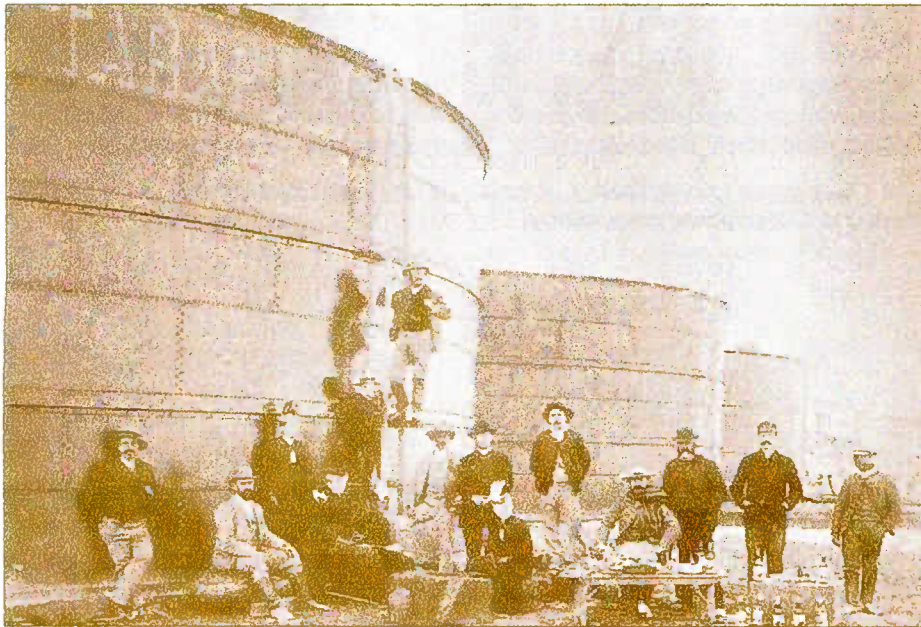
Foto 21: Trabajos de Agua de Tarapacá.
