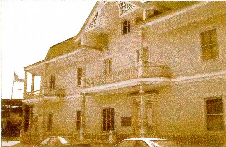
Foto 19: Palacio Astoreca Iquique: Construido en el siglo XIX. Durante un tiempo funcionó allí la Intendencia Regional. Actualmente es ocupado por la Universidad Arturo Prat de Iquique.
