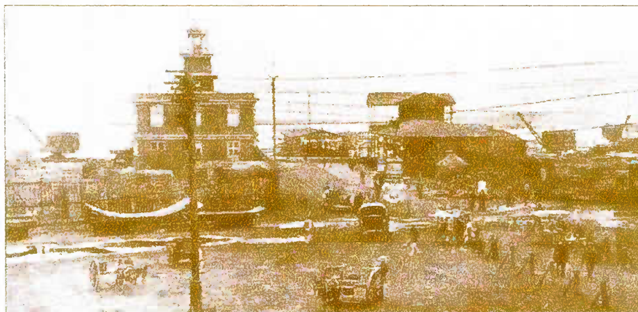
Foto 11: Edificio de la Gobernación Marítima y Muelle de Pasajeros, al finalizar el siglo XIX.
